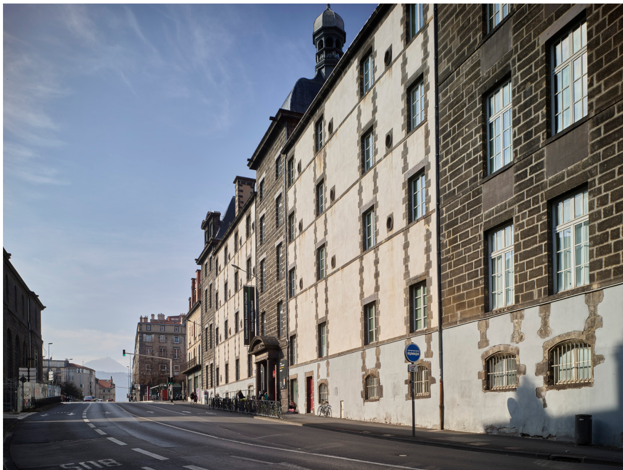
Elévation principale, depuis l'est
