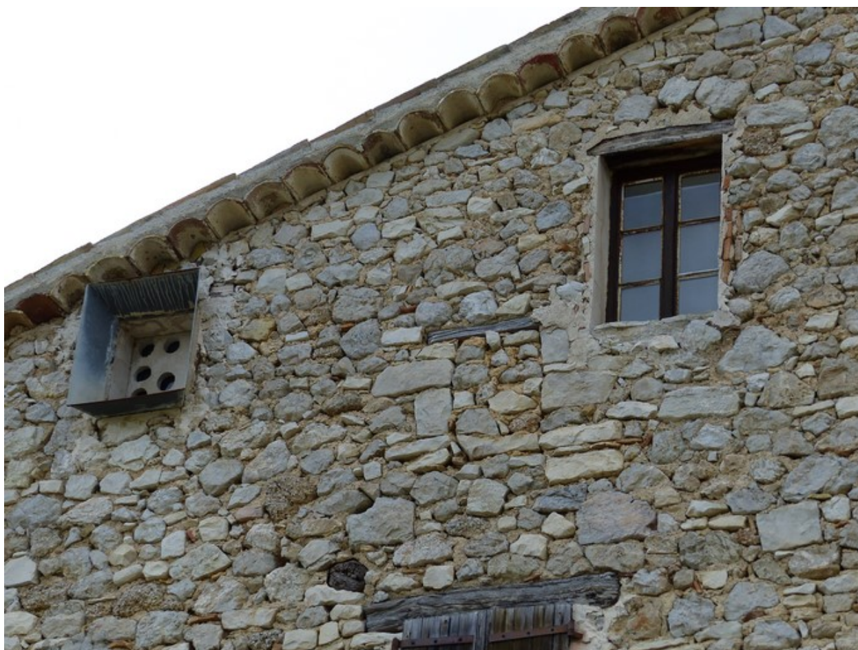
Pignon sud, troisième niveau. Jour muré.
