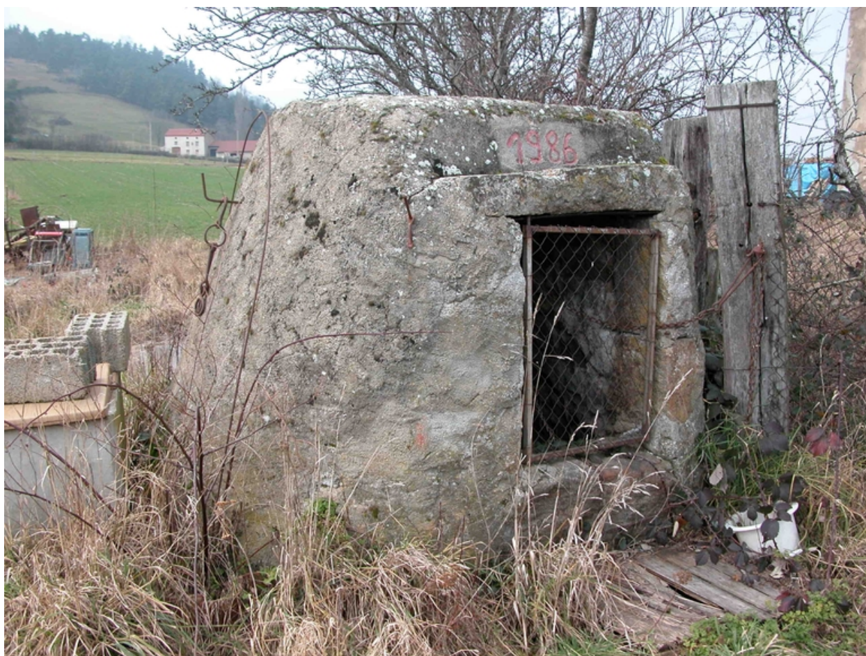
Vue du puits (parcelle 1986 I 339).
