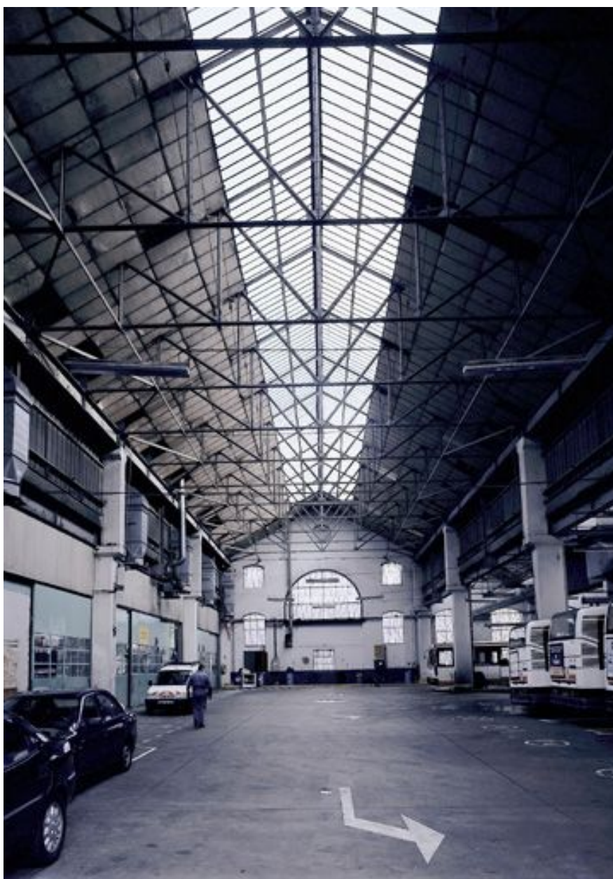
Halle de montage, vue intérieure ouest
