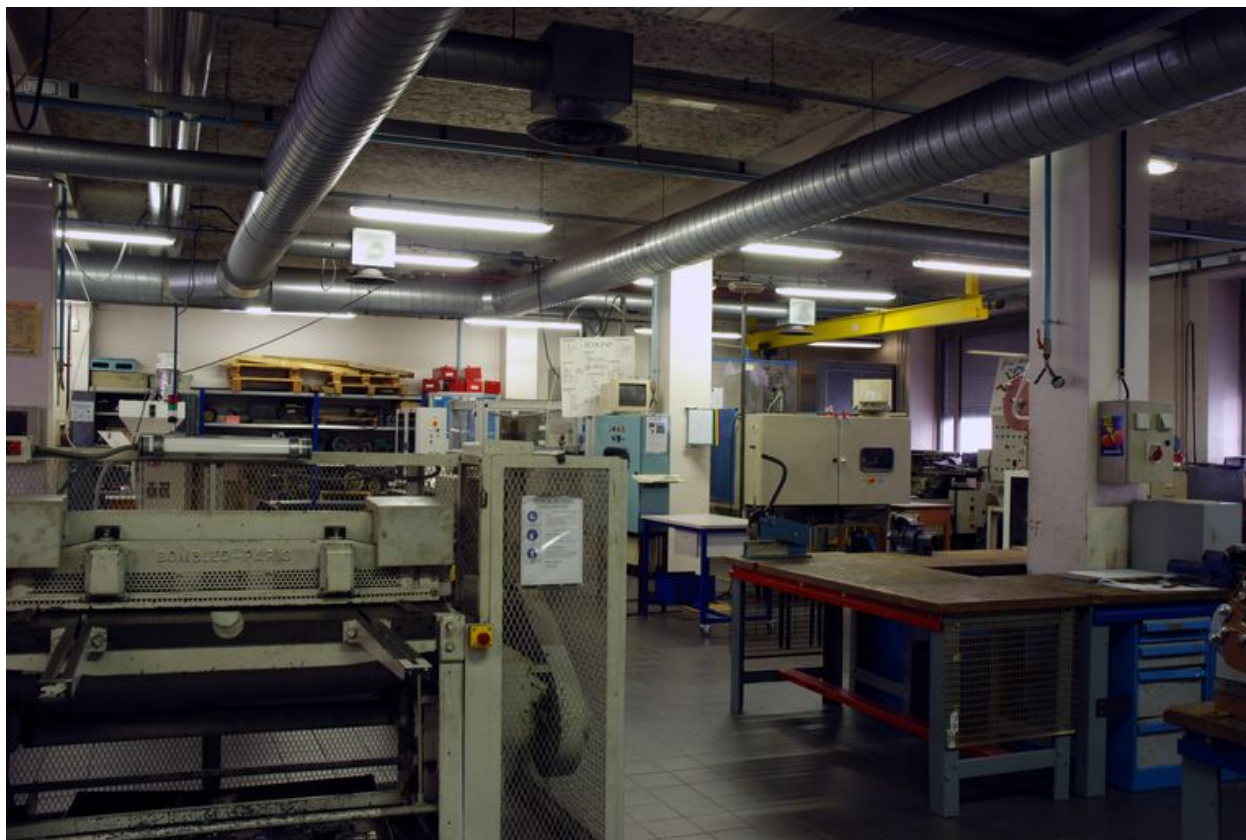
Vue générale de l'atelier de maintenance générale
