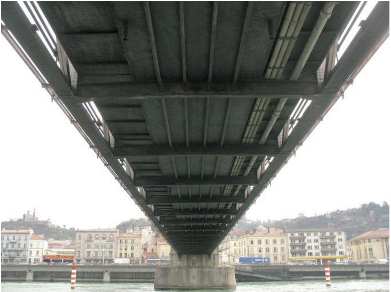
Vue partielle, de dessous, tablier et pile (depuis la rive droite)
