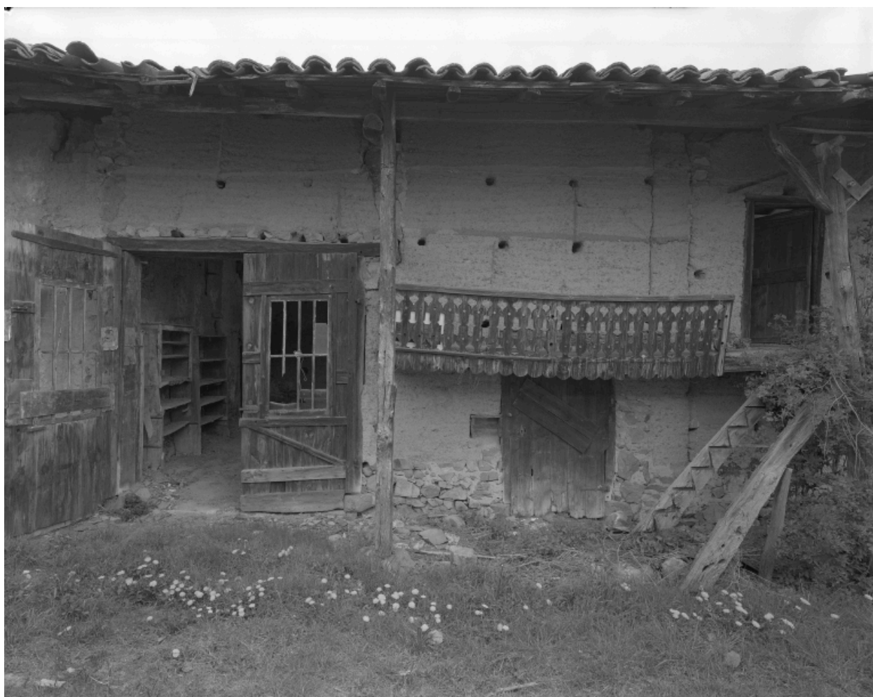
Façade des dépendances : cuvage, étable et grenier.
