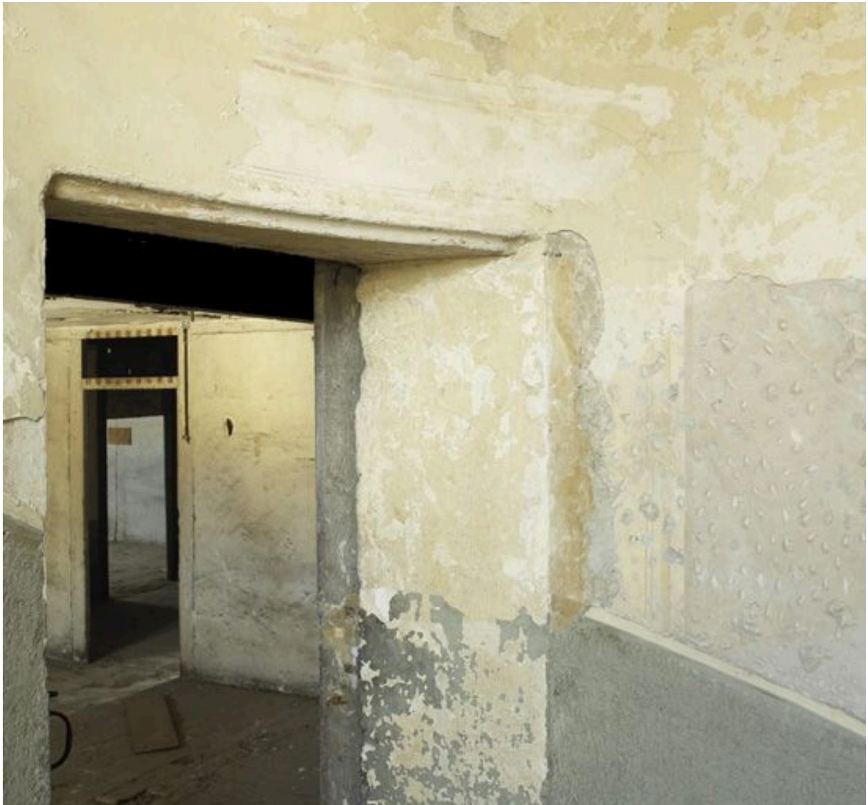
Corps de bâtiment ouest. Escalier principal. Peintures
