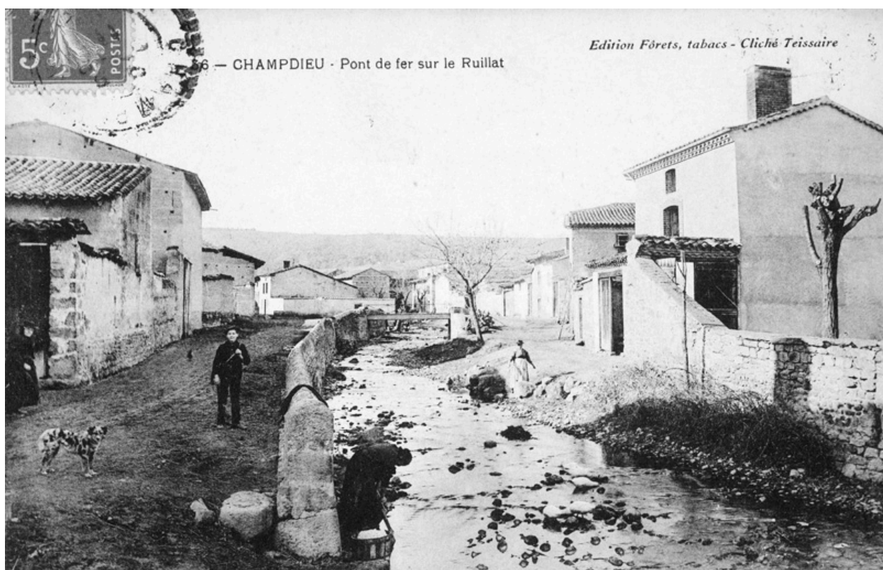
36 - CHAMPDIEU - Pont de fer sur le Ruillat.
