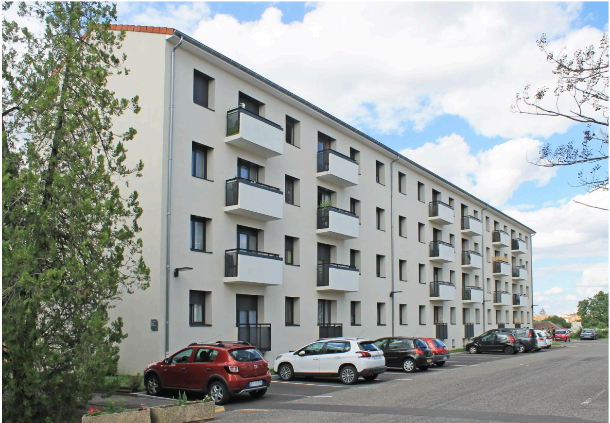
Riom, la cité HLM de la route de Marsat, bâtiment D vu du sud.
