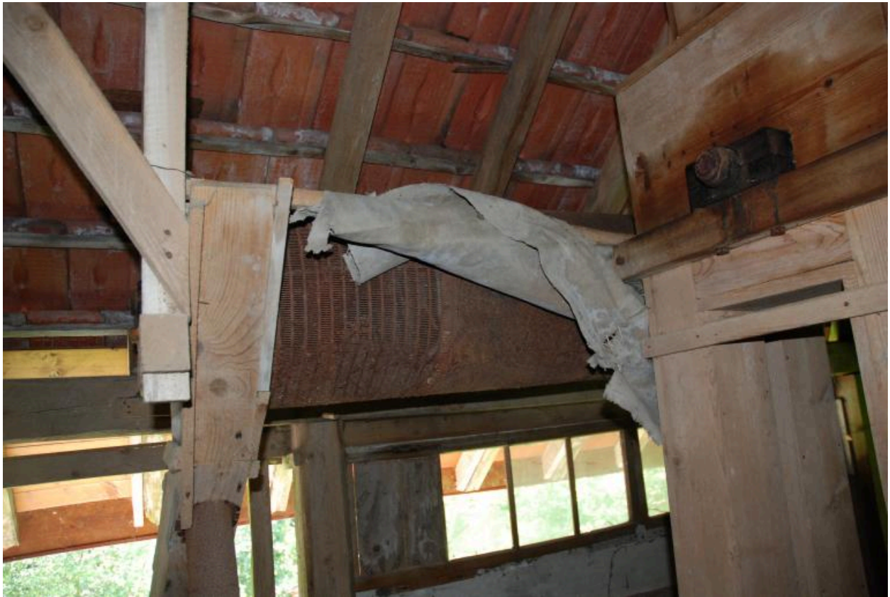
Vue intérieure du comble, partie nord : trieur à grains, trémie.
