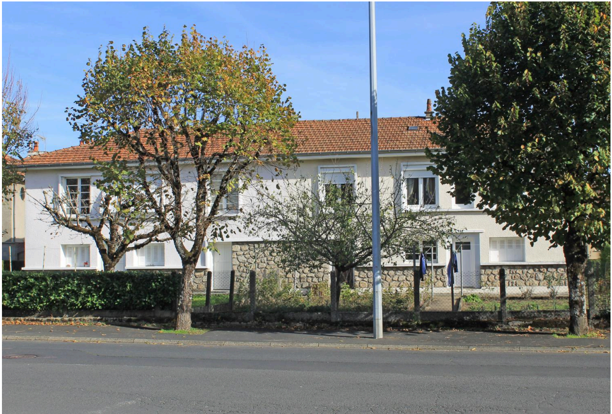
Aurillac, lotissement Andrieux (mitoyen de la cité des Camisières), maisons jumelées n° 14 et 16 rue de la Cère, façades postérieures, Georges Breuil architecte.
