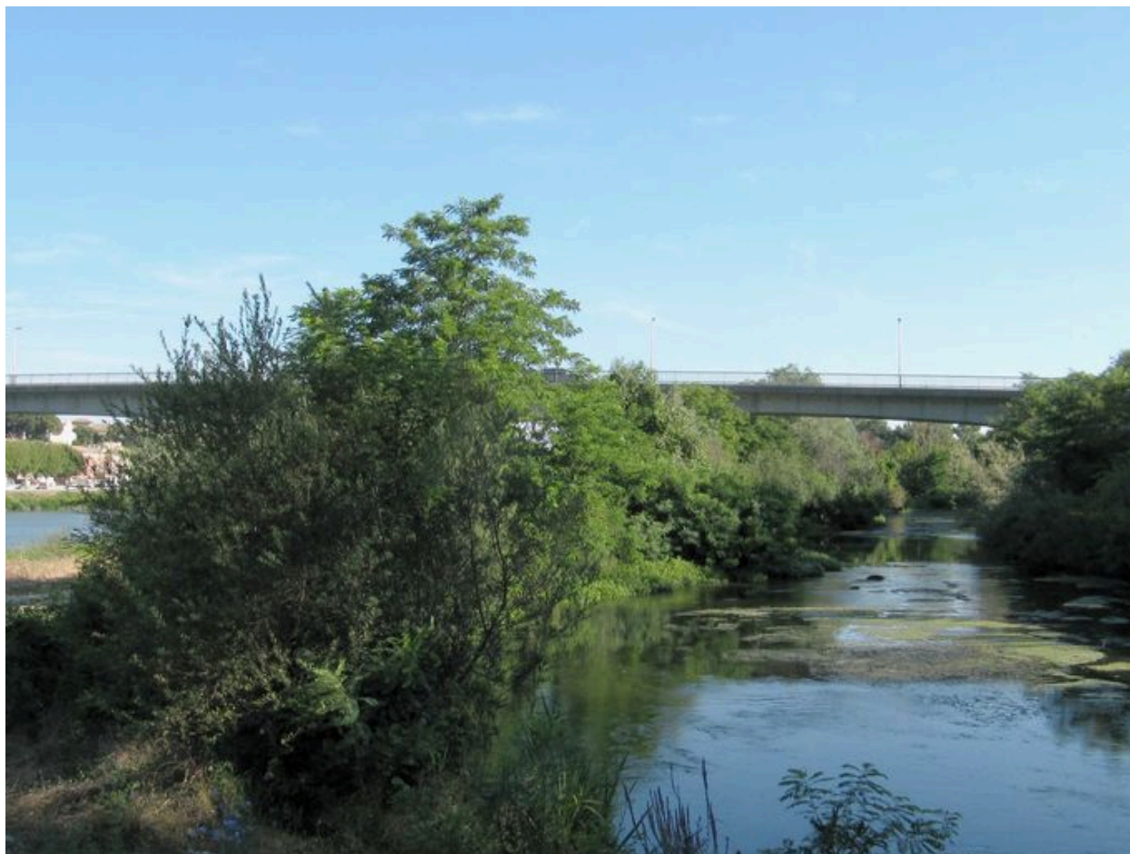
Vue partielle, travée gauche, face aval (depuis la rive gauche)
