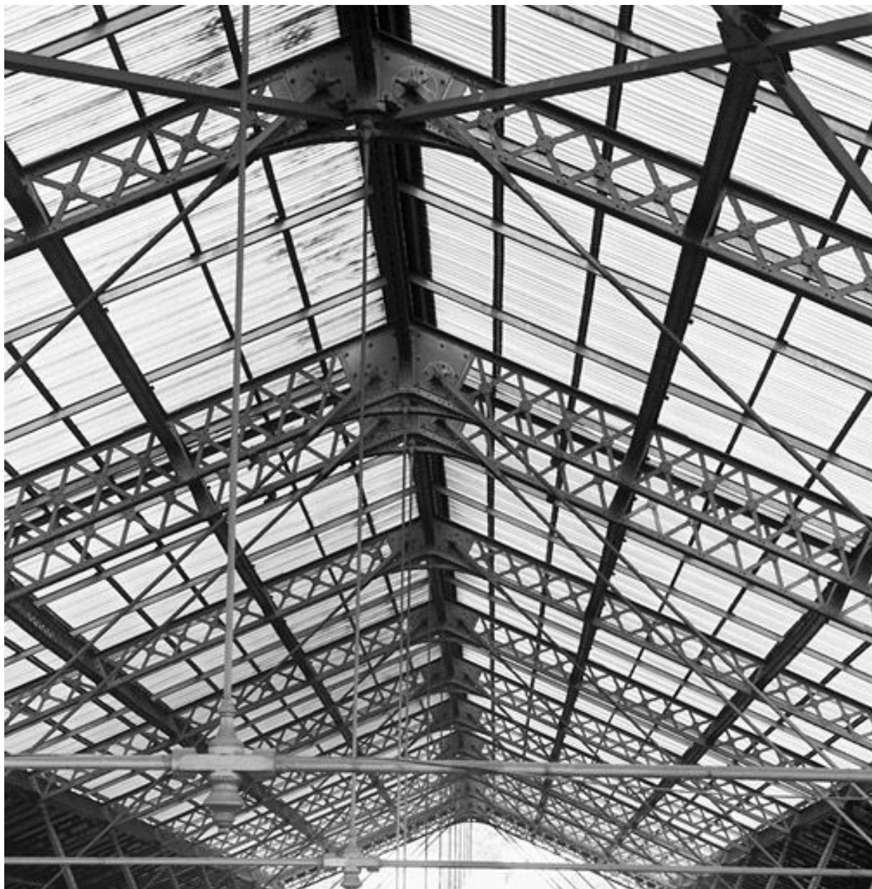
Vue partielle de la charpente de la grande halle
