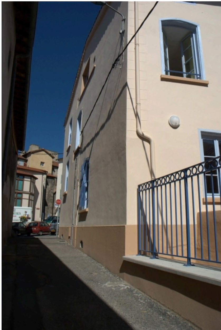
Îlot 2. Saint-Jean (rue) 40 / Saint-Jean (traversière) 1 / Roanne (rue de) 17. Vue générale de la façade sur la traversière du second corps de bâtiment de la maison.
