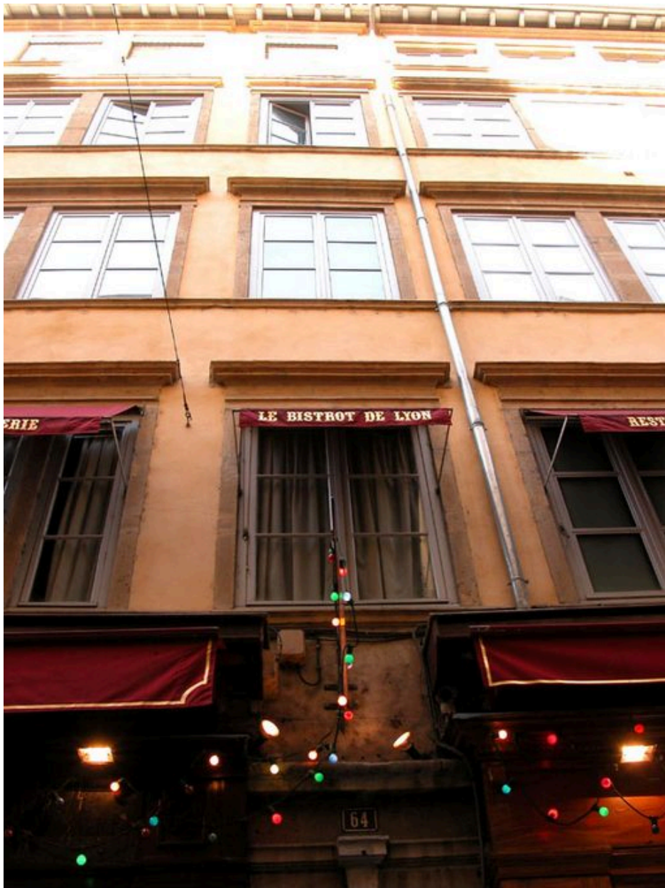
Vue partielle des étages carrés
