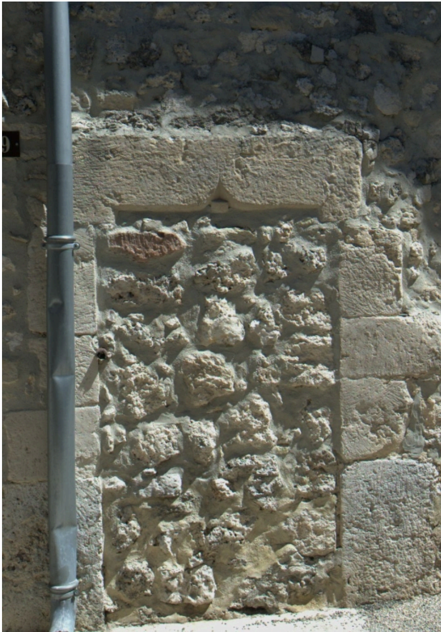
Façade, 17 Grande rue, détail : porte murée à linteau orné d'une accolade.
