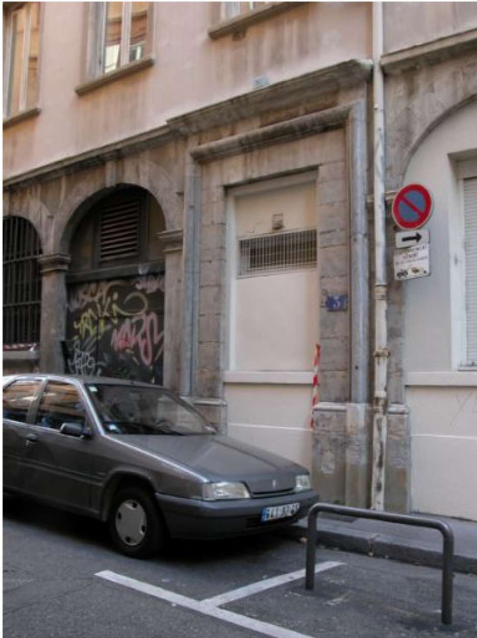
Façade rue des Forces, ancienne porte
