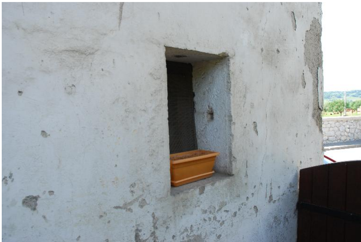
Façade est, détail d'une petite baie du rez-de-chaussée surélevé.
