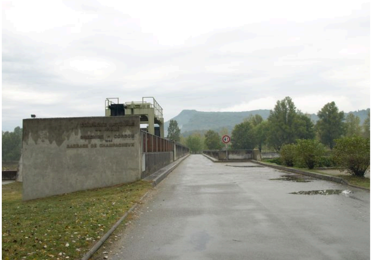
Pont amont : chaussée (depuis la rive gauche)
