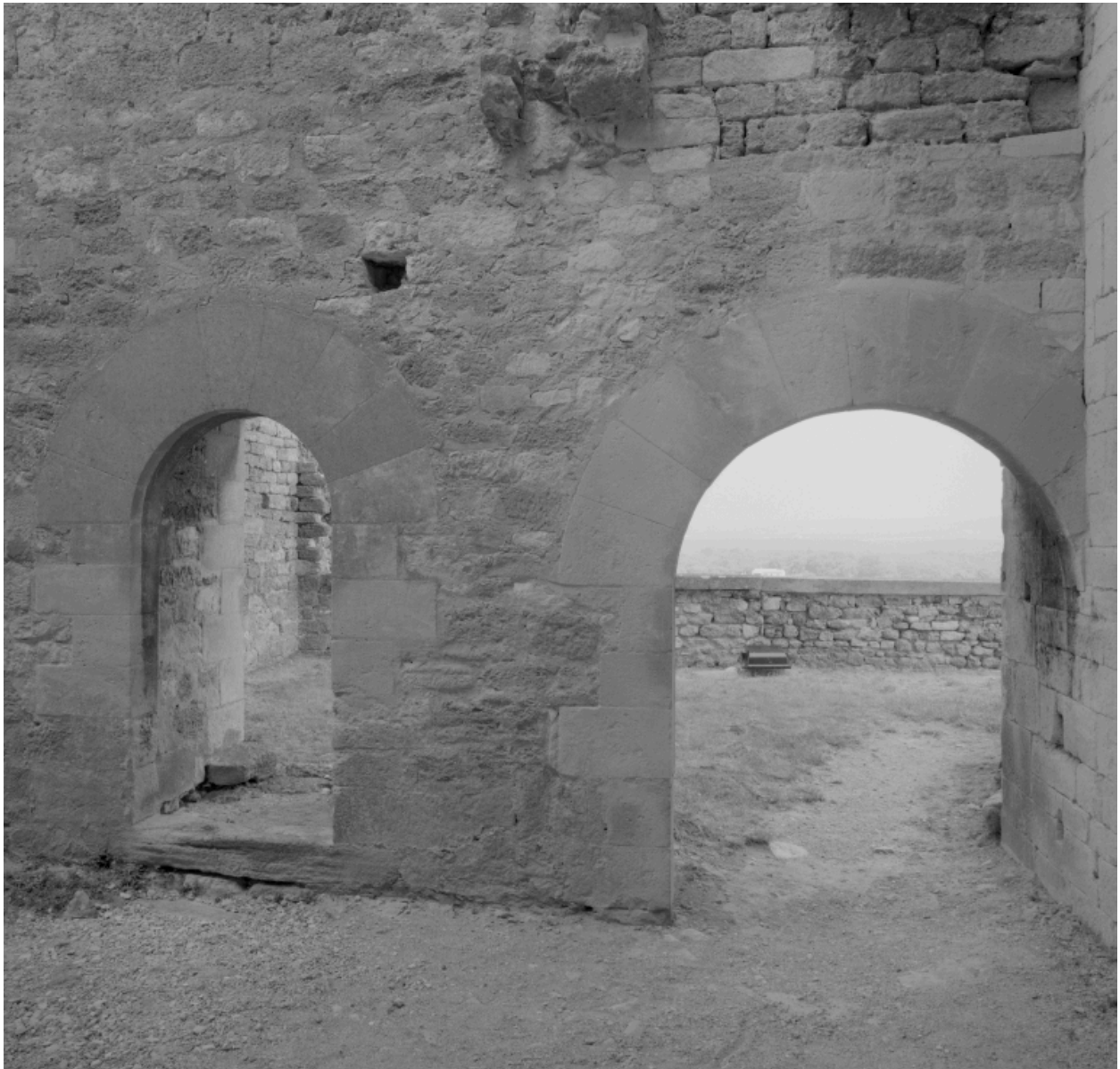
Bâtiment ouest, portes du mur nord.
