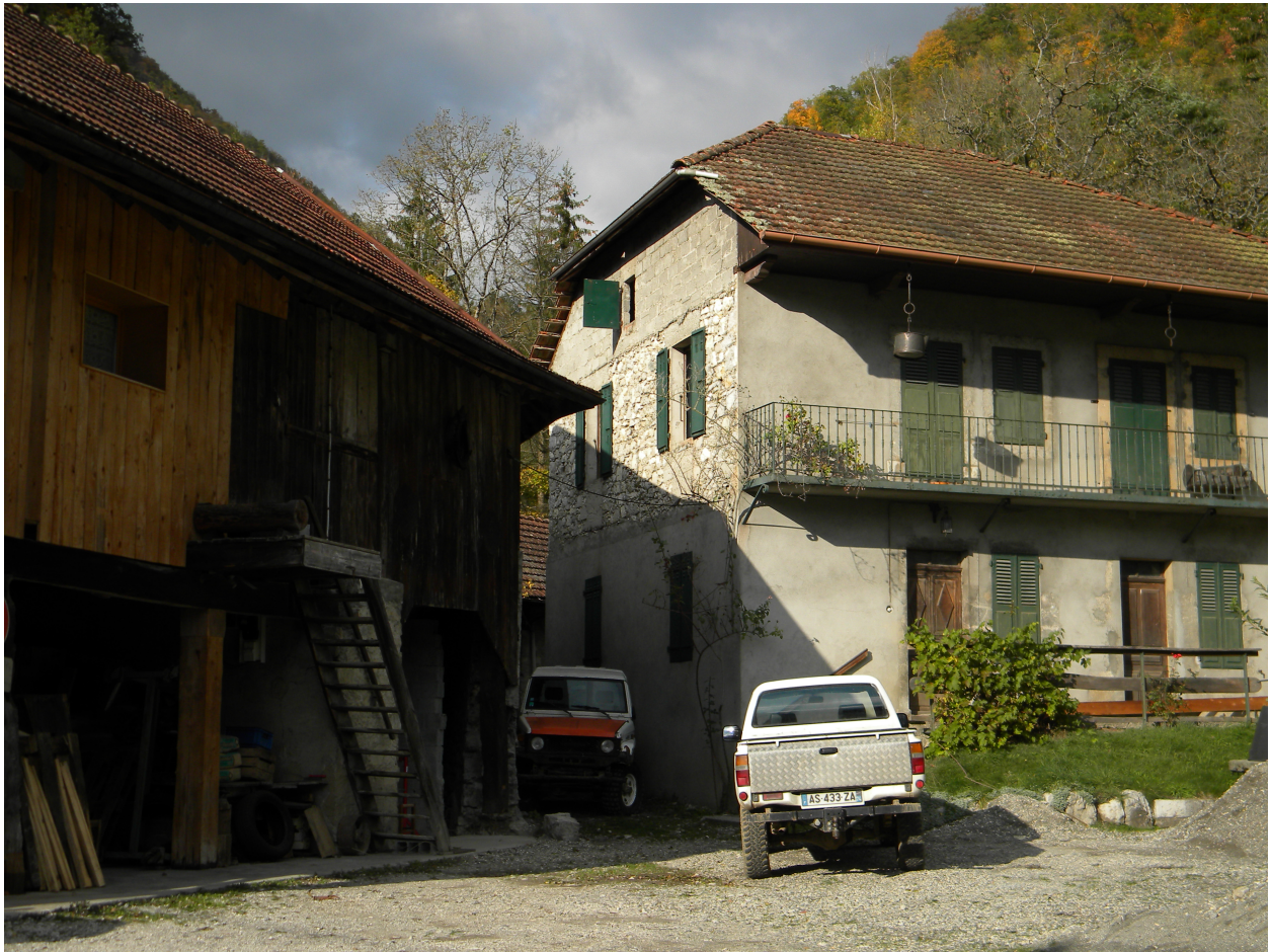
Vue de la séparation entre la scierie et l'habitation.
