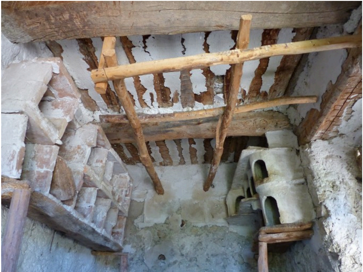
Rez-de-chaussée surélevé. Perches et boulins.
