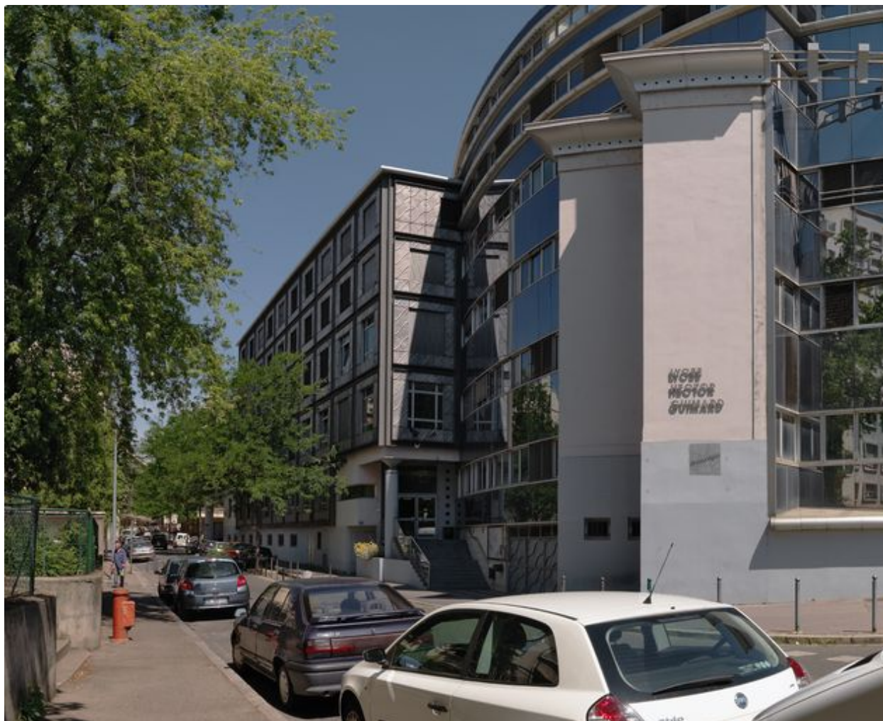
Elévation principale depuis le sud-ouest
