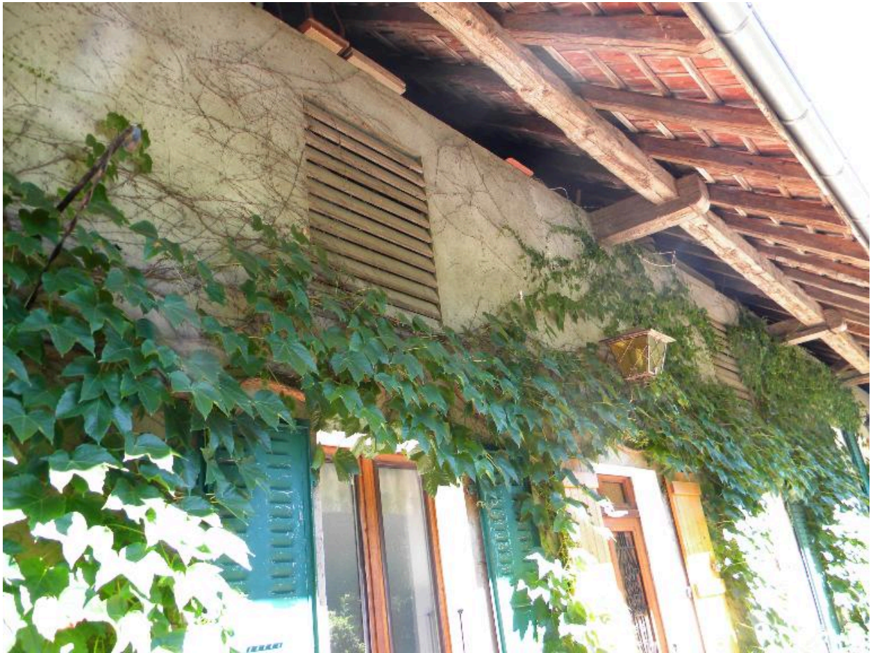
Vue des poutres solives sous le débord de toit (2008 F4 603).
