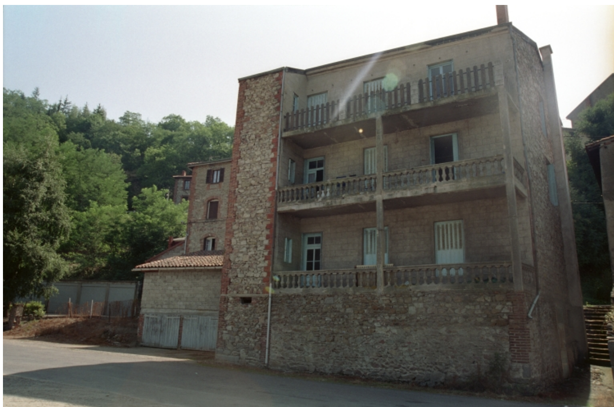
Boën, îlot 24, Philippe Raymond (rue) - parcelle AP 131. Vue générale de la façade arrière..
