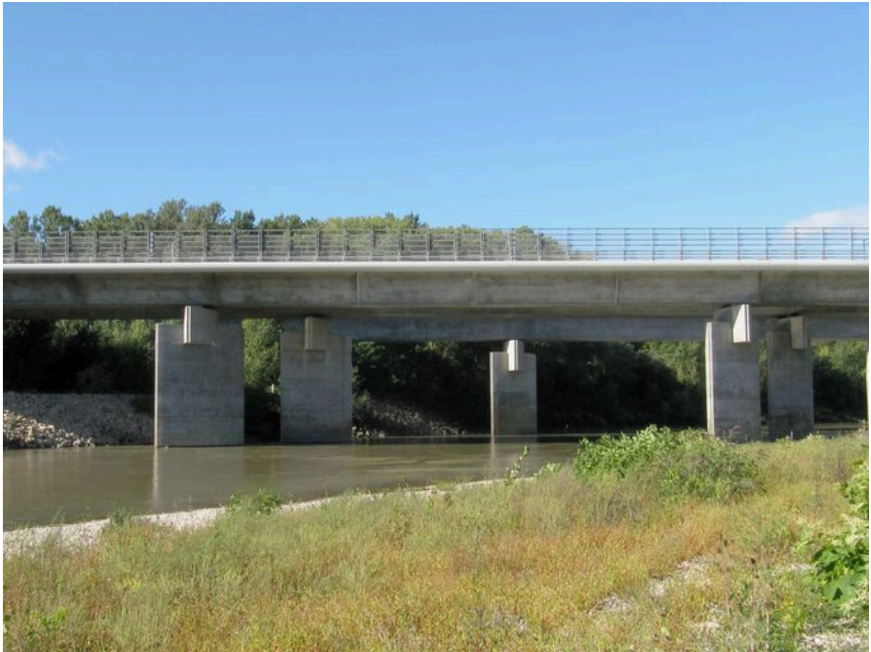
Vue générale de la partie du pont sur le canal de Miribel, face amont (depuis la rive droite)
