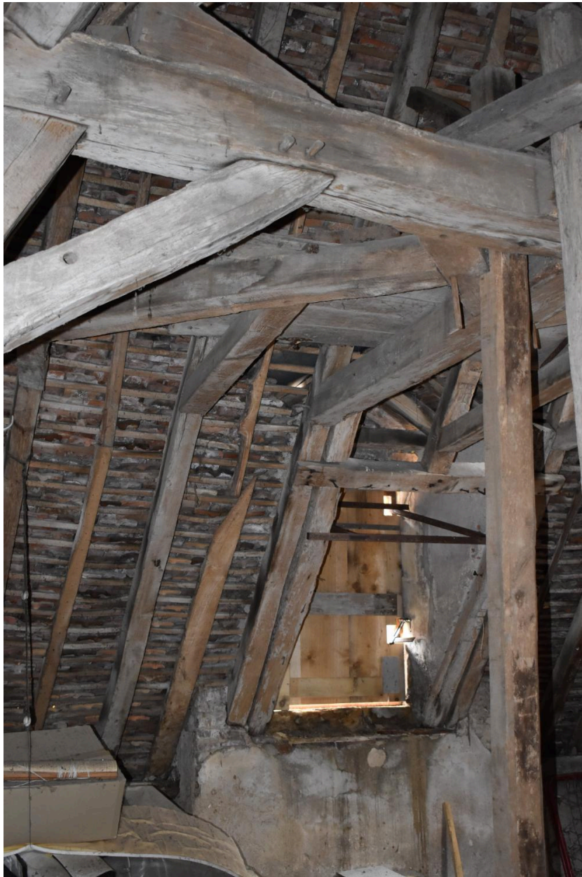
Vue de détail de la charpente du comble : croupe au niveau de la lucarne.
