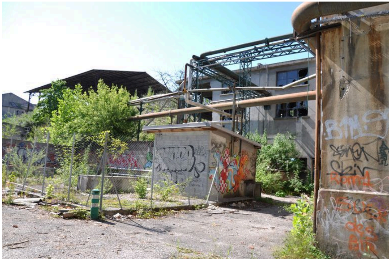
Bâtiment de la chaufferie côté Thiou.
