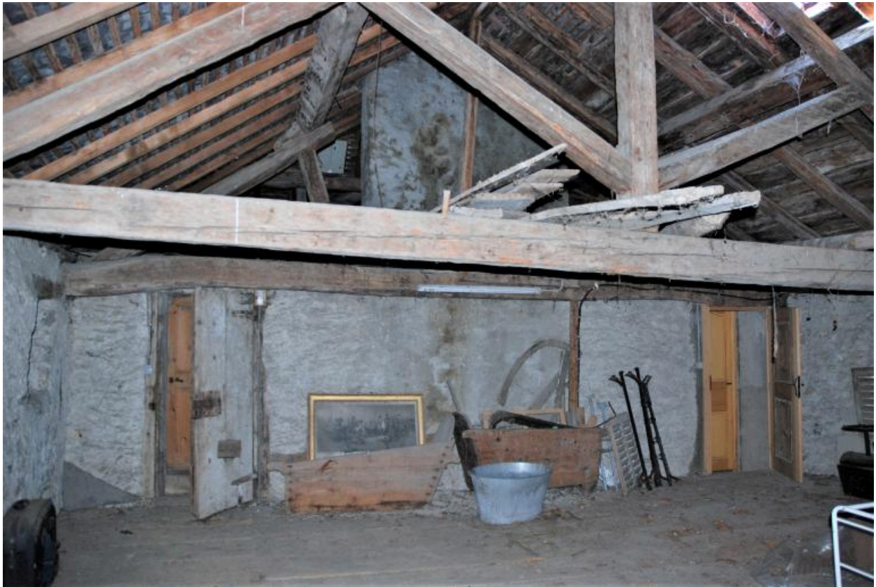
Etage de comble, vue en direction du sud, mur extérieur et portes des deux chambres sud.
