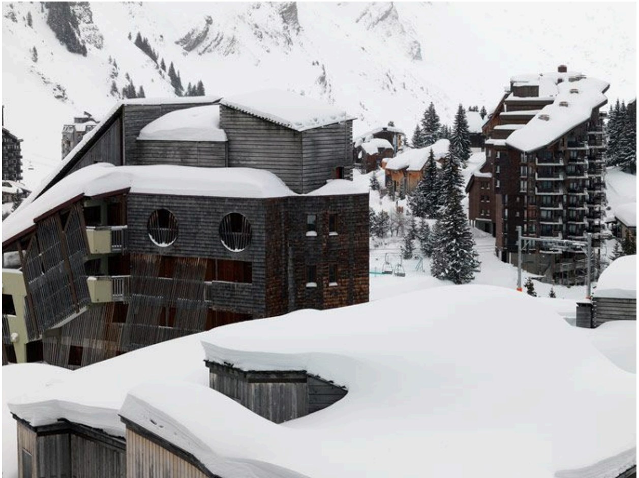
La station sous la neige
