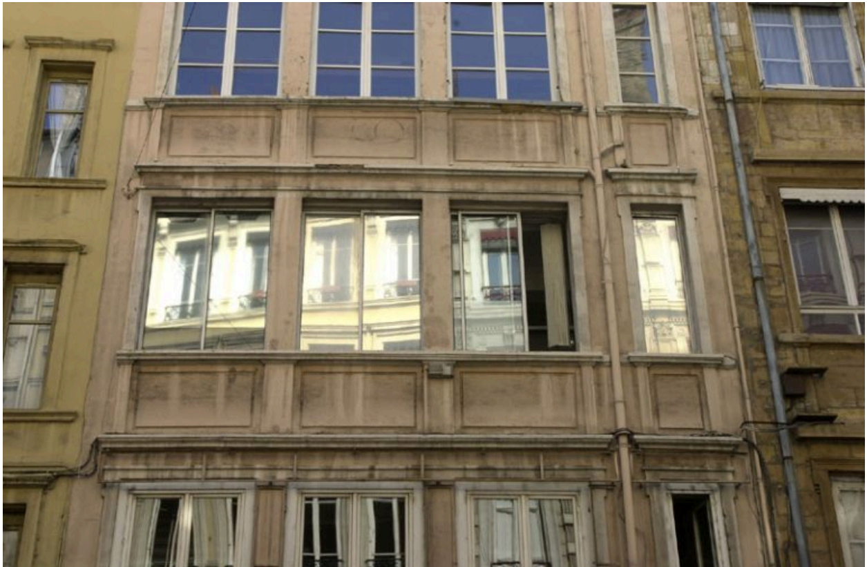
Façade sur la rue de Brest, 3e niveau
