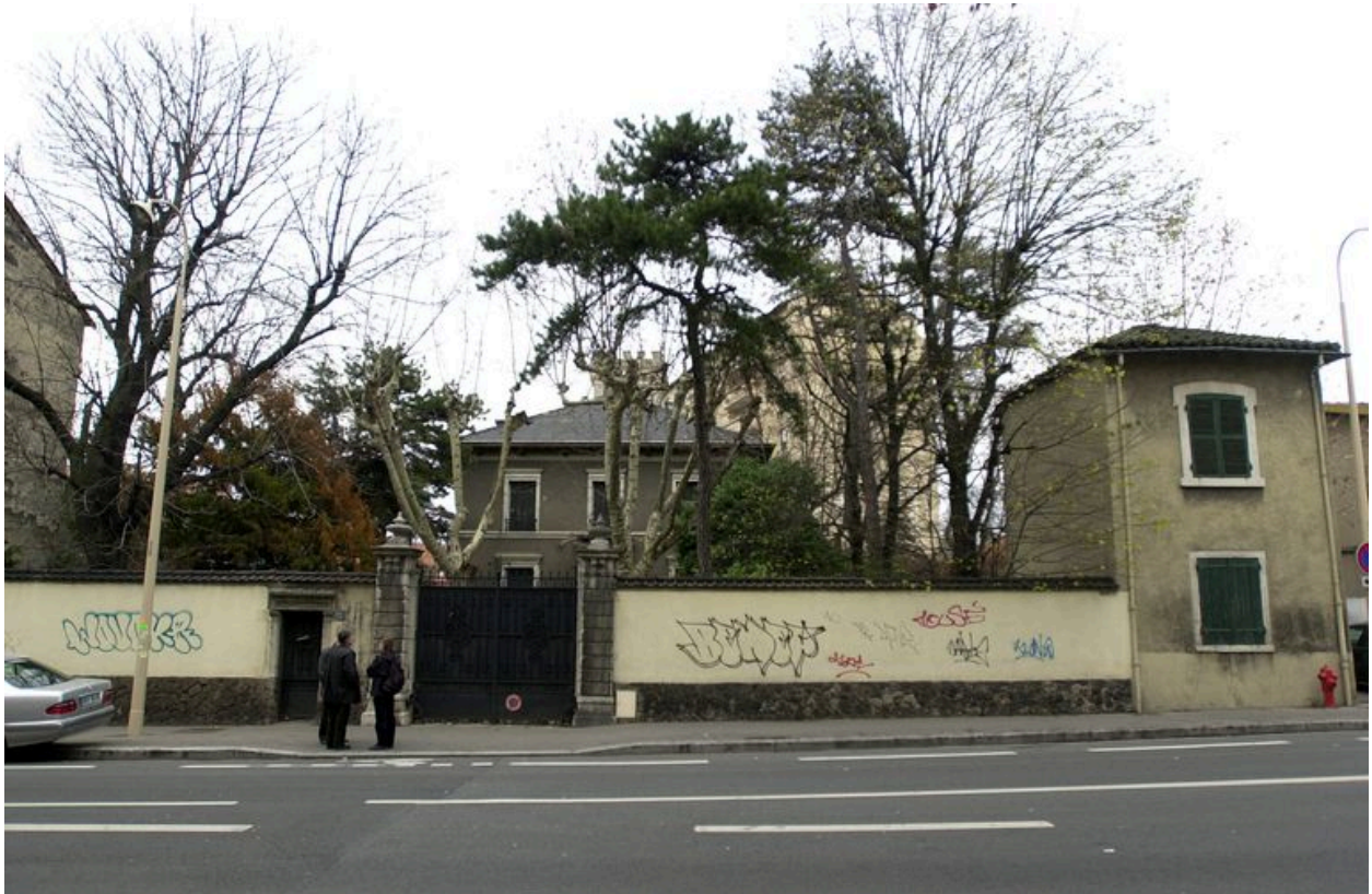
Vue générale depuis la route de Vienne
