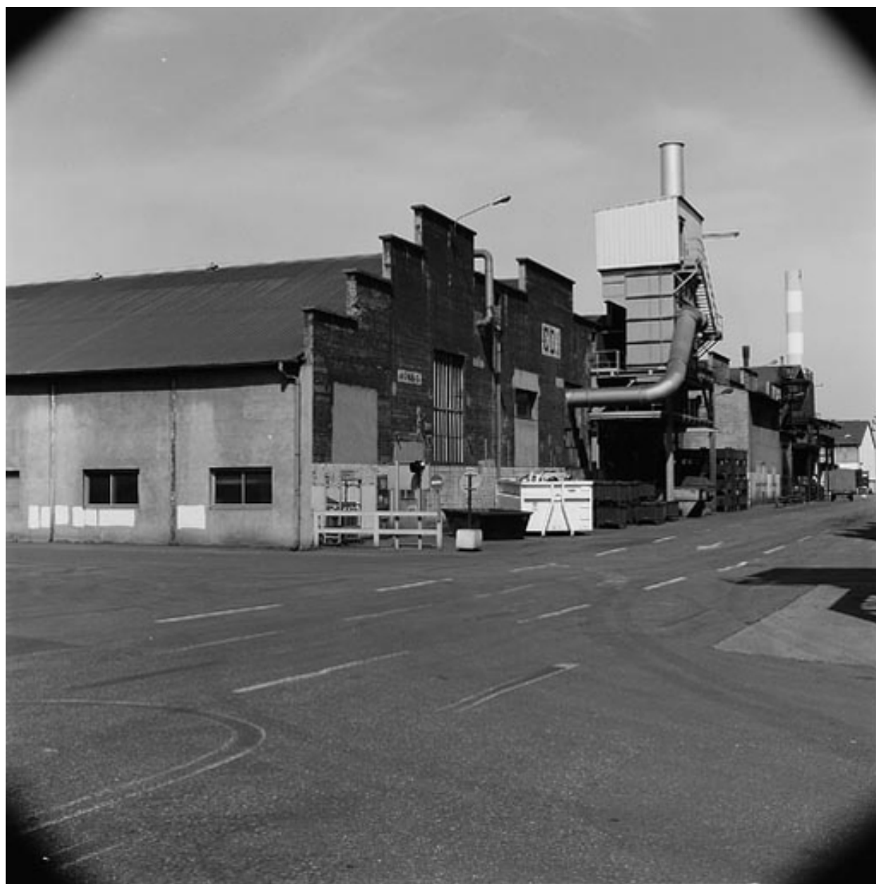
Fonderie, vue nord.
