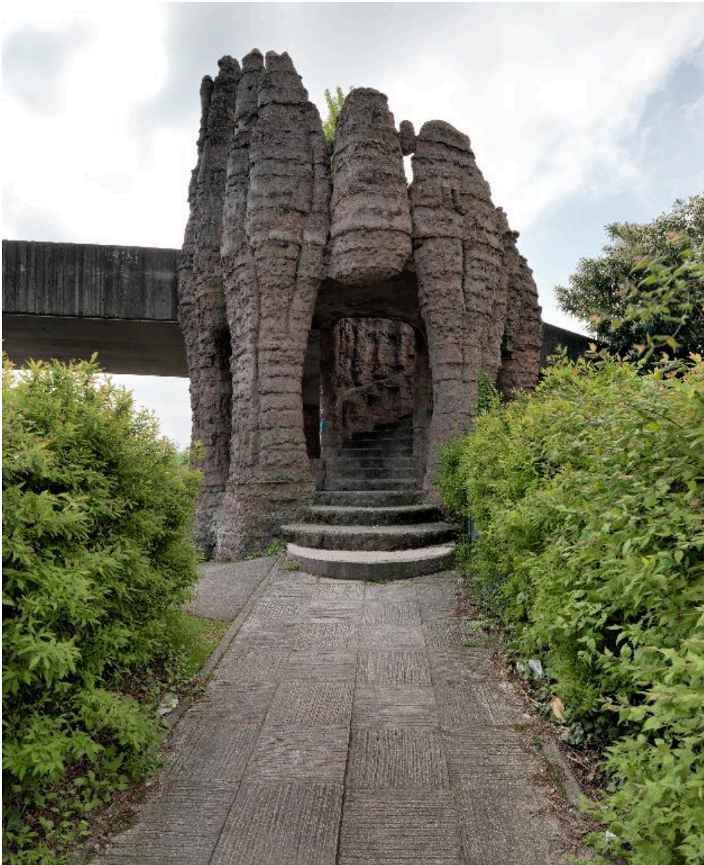
Elément monumental intégré à l'extrémité de la passerelle et à l'escalier en vis
