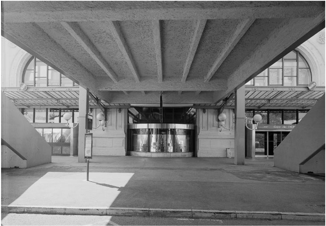
Le bâtiment-voyageurs : élévation nord, travées centrales du rez-de-chaussée depuis la voie située sous le mail reliant le centre d'échanges à la gare
