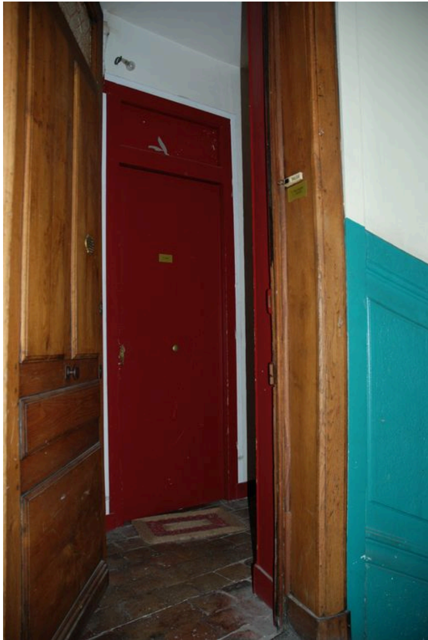
Vue d'une porte palière, ouvrant sur un couloir desservant deux appartements (?), au 3e étage
