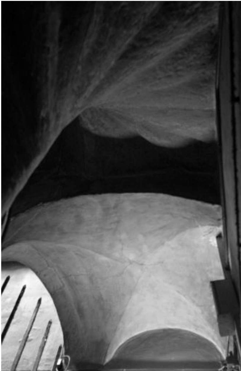
Escalier et voûte d'arêtes d'un palier, détail
