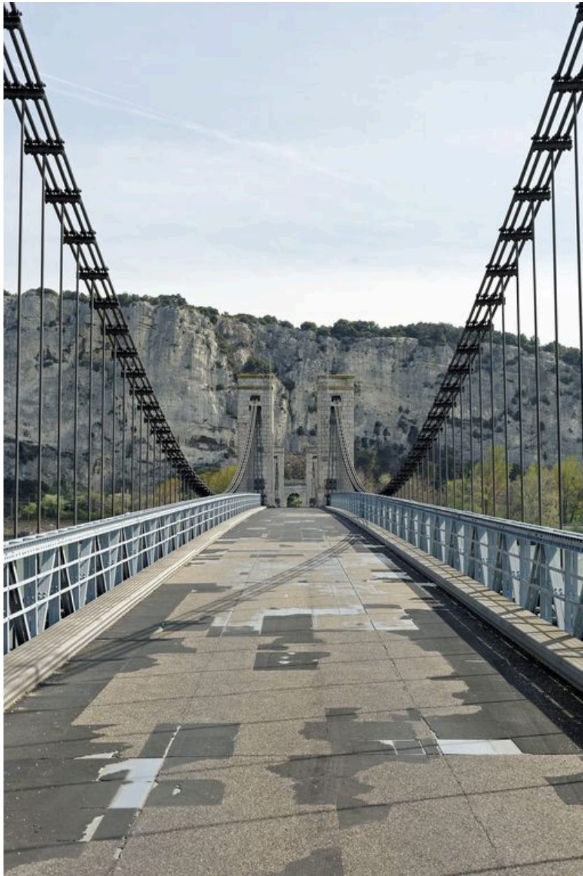
Sur le tablier, vue de la chaussée (vers l'est) [mars 2009]
