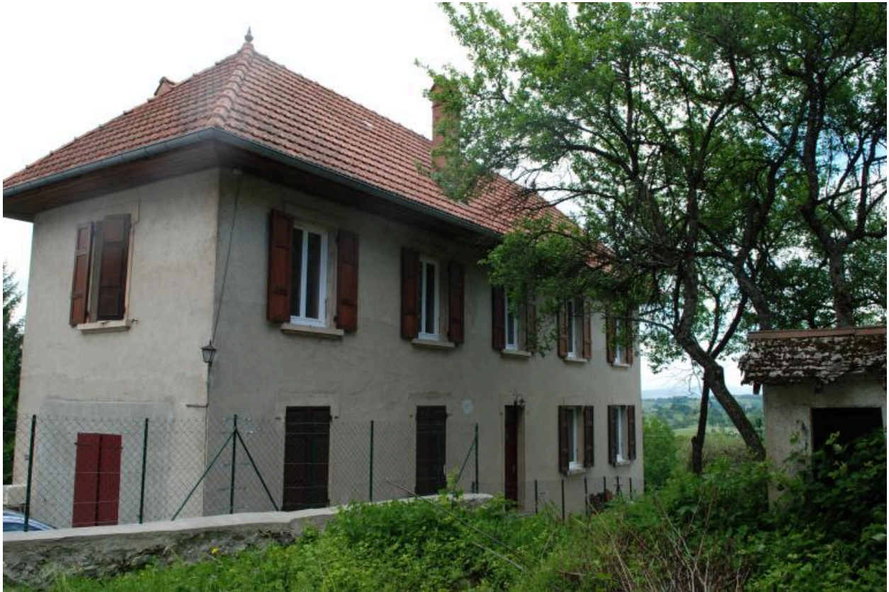
La Troppaz, ferme, 2015 B11 759. Vue d'ensemble de trois-quarts avant gauche.
