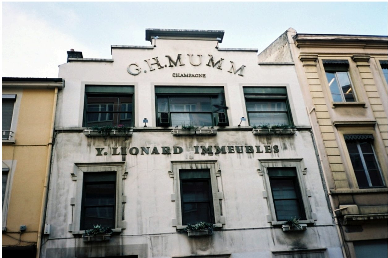
Détail du haut de la façade sud
