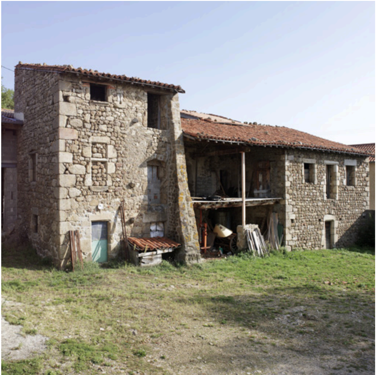
Vue d'ensemble de trois-quarts sud-ouest du château du Soleillant.
