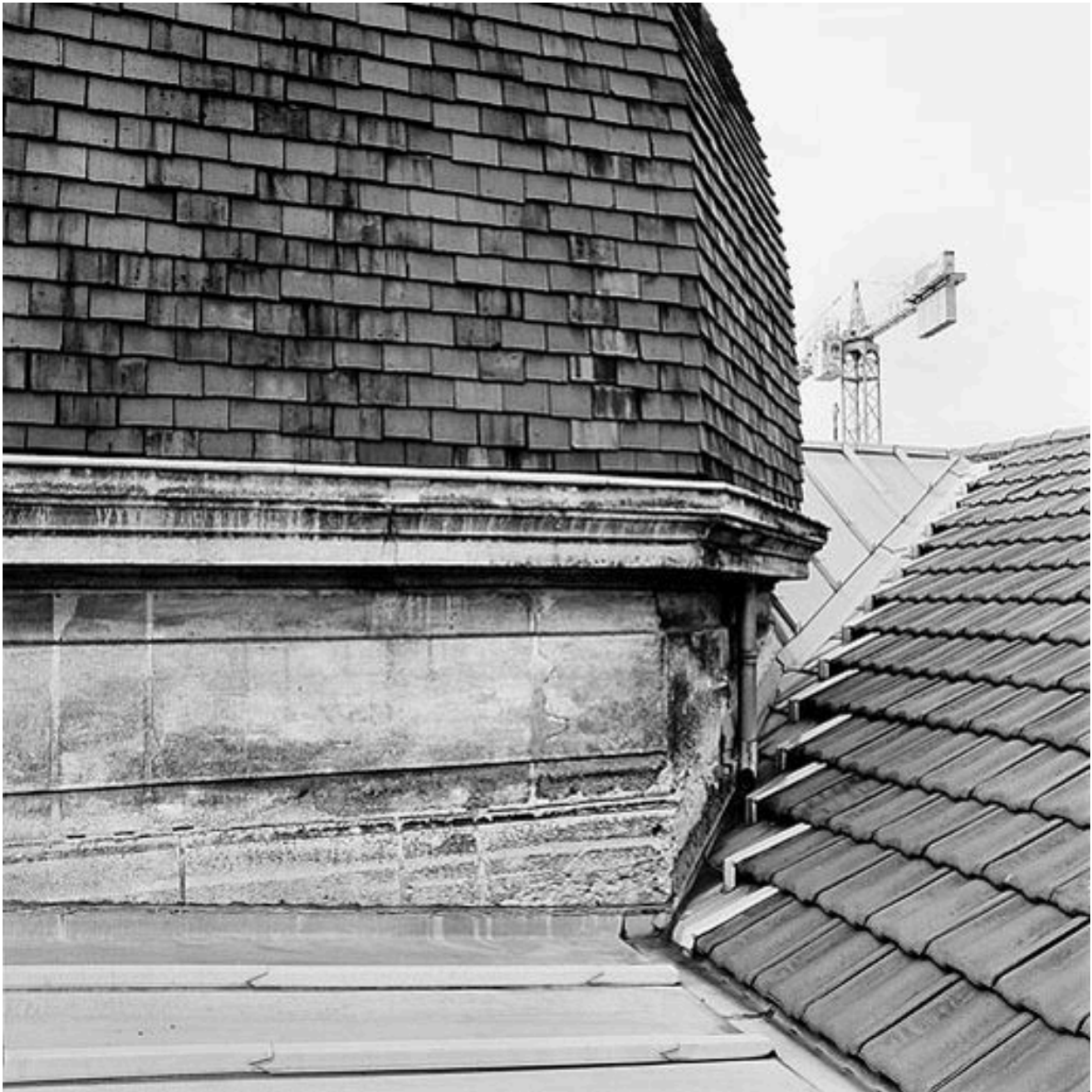
Détail du dôme de la tour d'escalier : jonction des toitures
