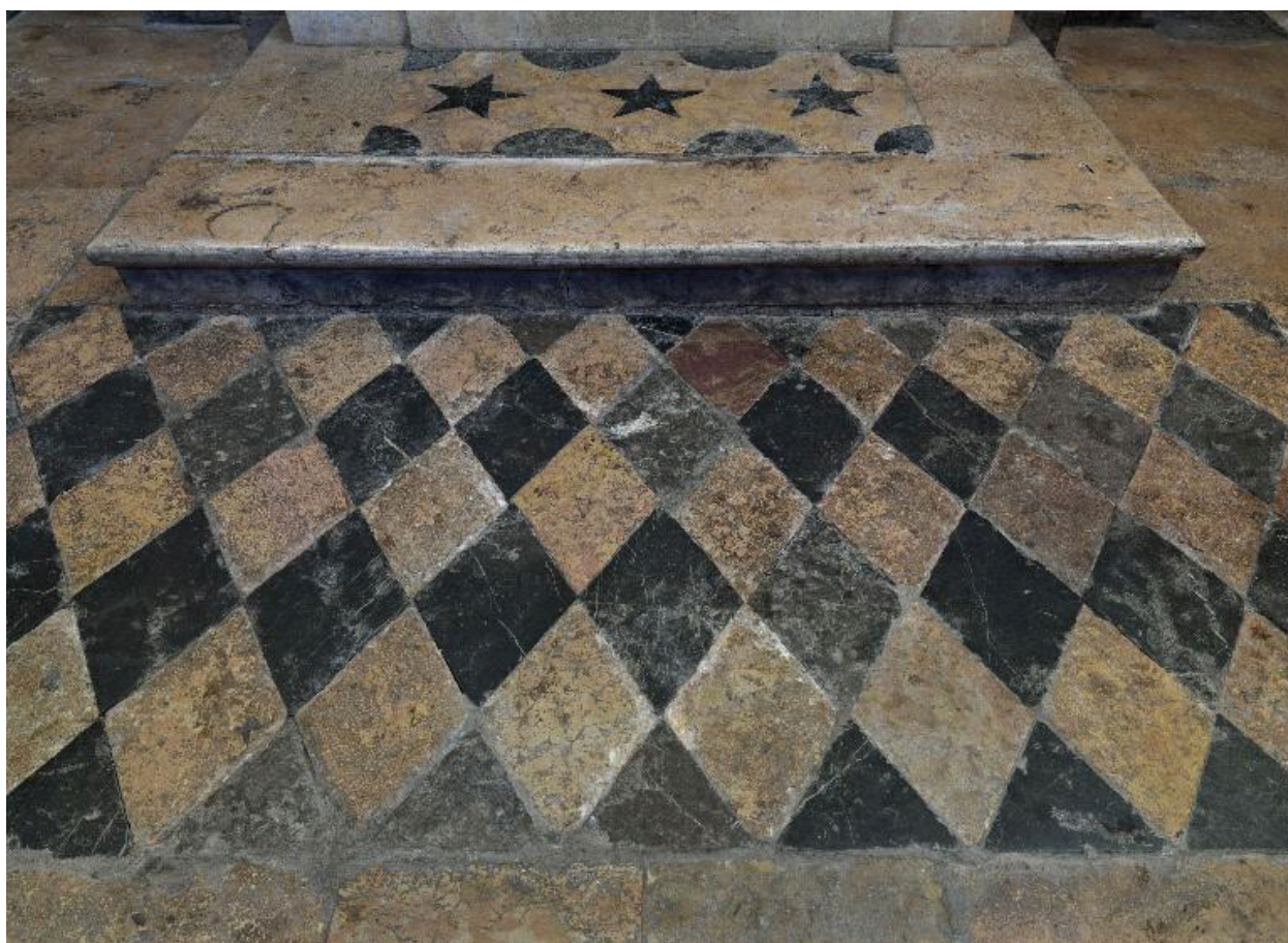
Détail du dallage
