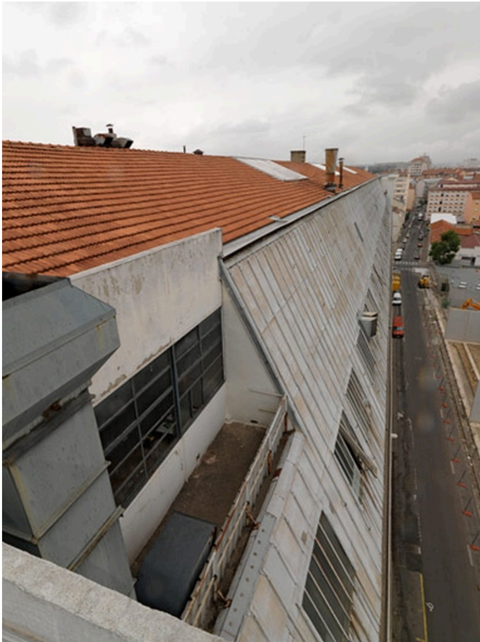
Balcon technique d'accès au toit
