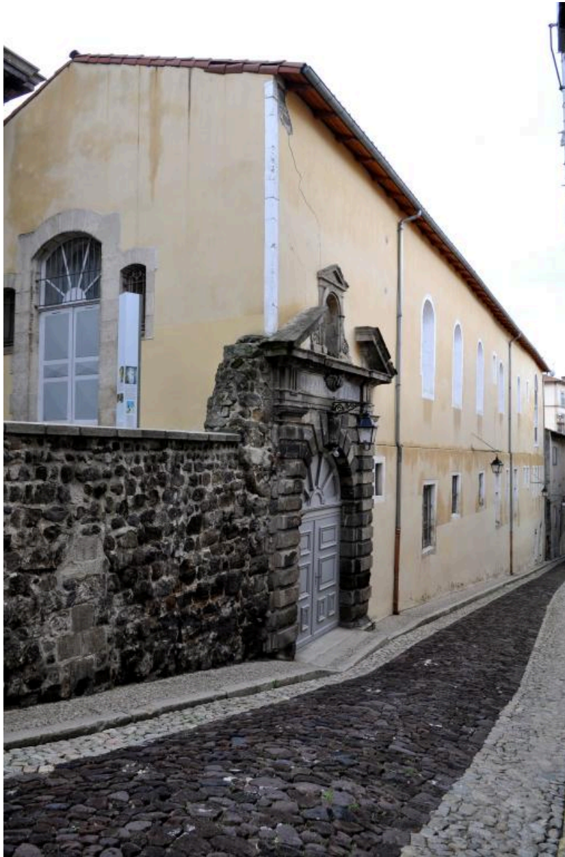
Bâtiment A, élévation sur la rue du Bessat depuis le nord
