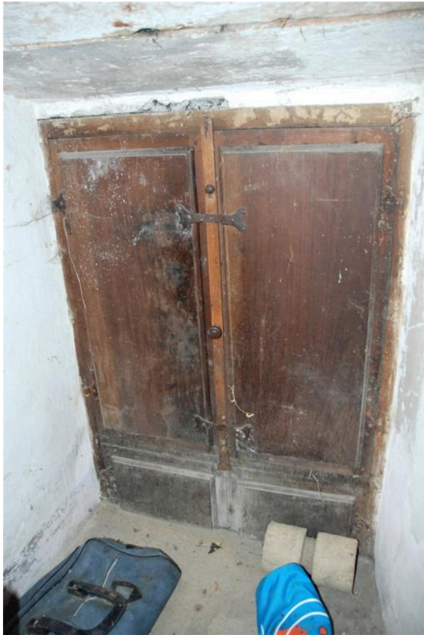
Corps principale, rez-de-chaussée, partie sud, réduit ouest, détail de la fenêtre avec volets intérieurs (Cf. Plan RDC 6a).
