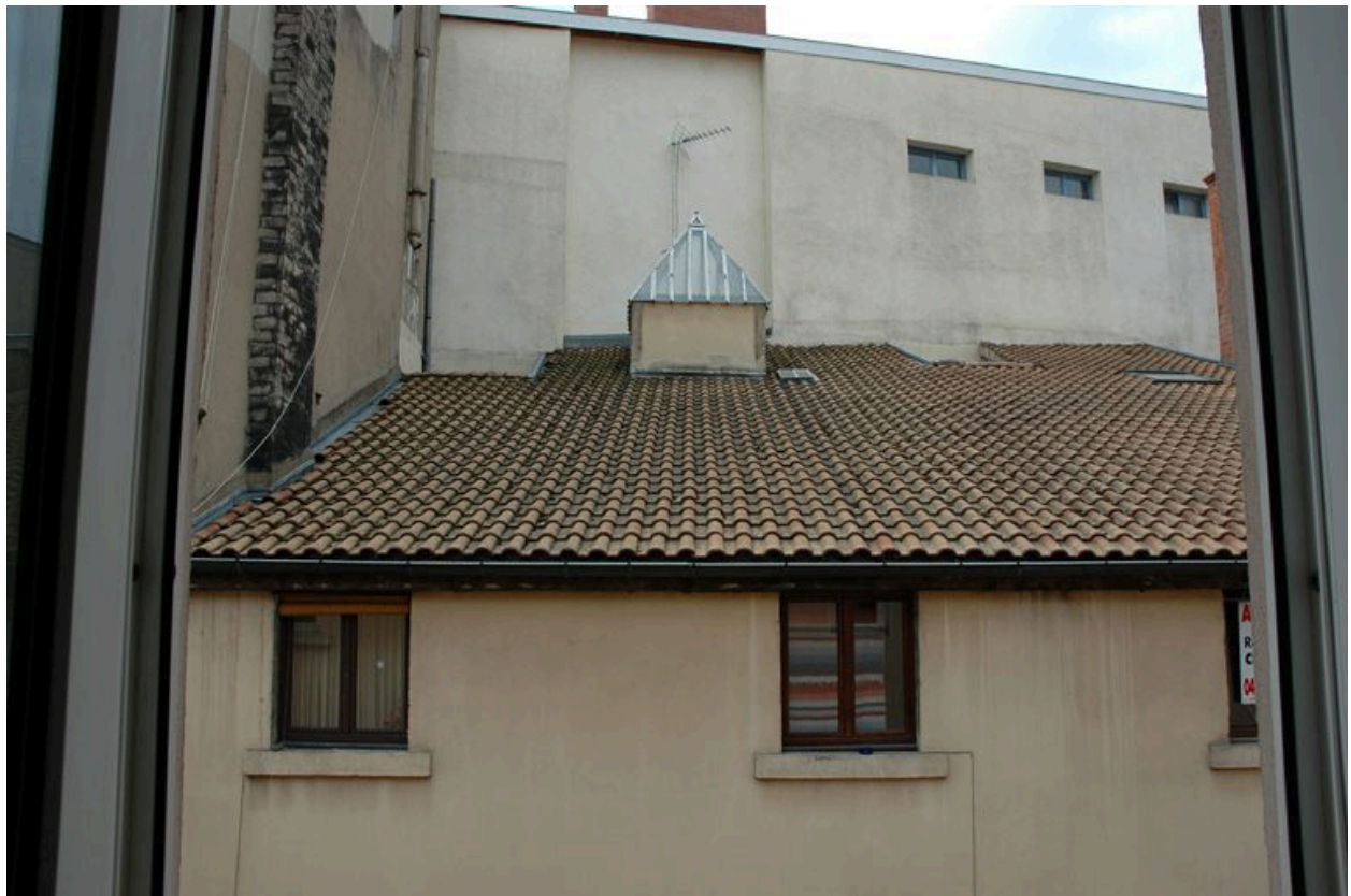
Vue partielle depuis l'escalier de l'immeuble sis 3 rue des Templiers
