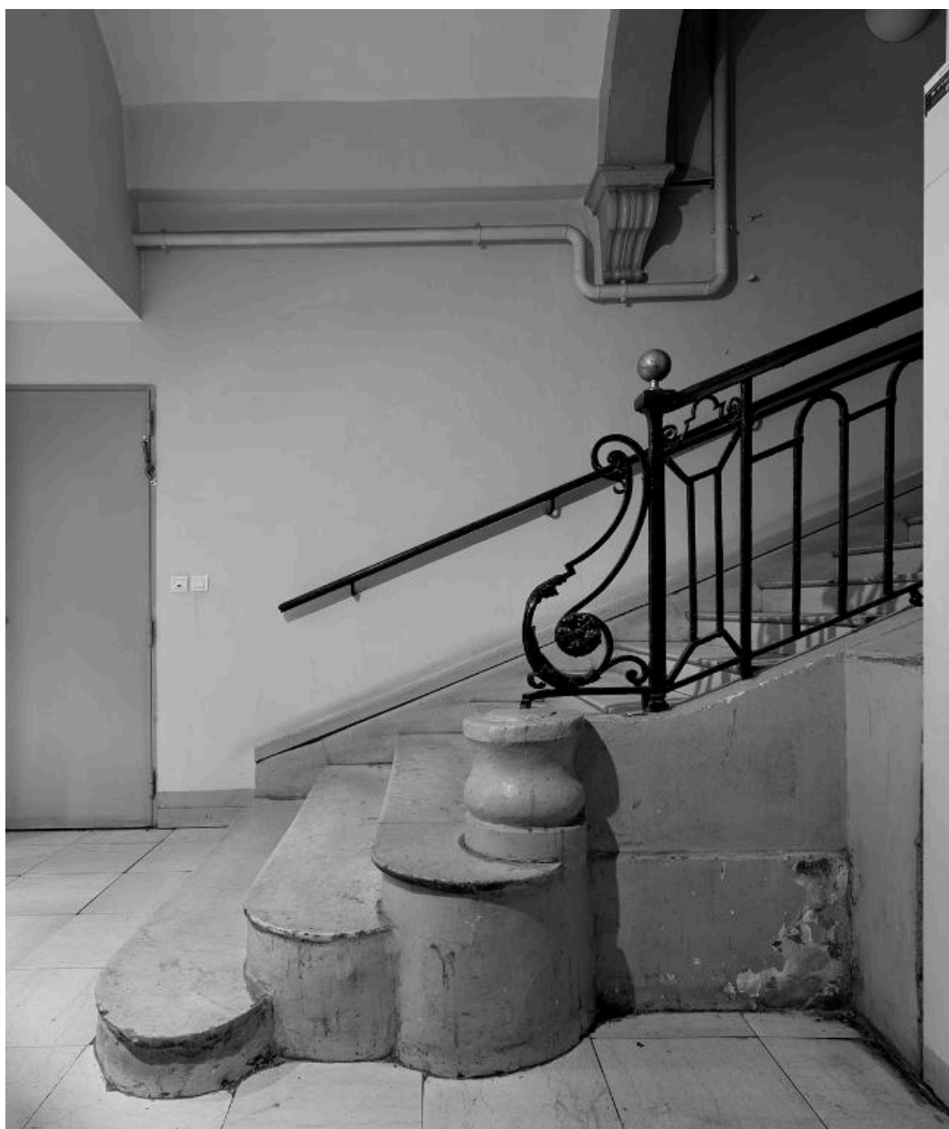
Escalier, départ de la 1ère volée
