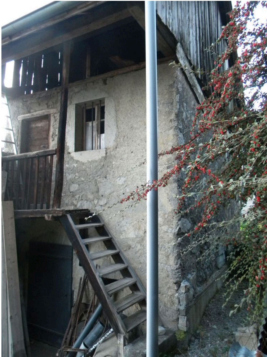
Vue la façade principale d'un ancien cellier mitoyen (2008 A8 1857)
